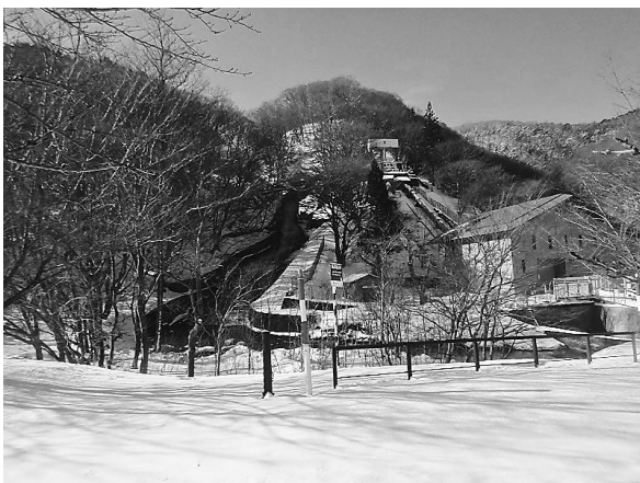
第1図 現在の沼上発電所
