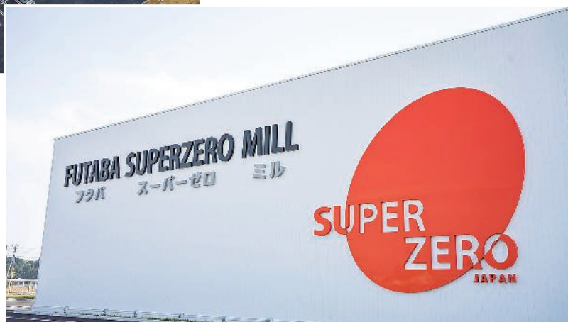
外観・壁面サイン
