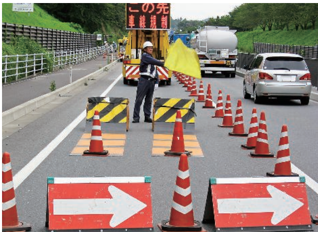
交通誘導警備の現場
