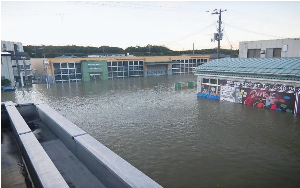
2019年10月 本社屋上から撮影、台風19号による被害
