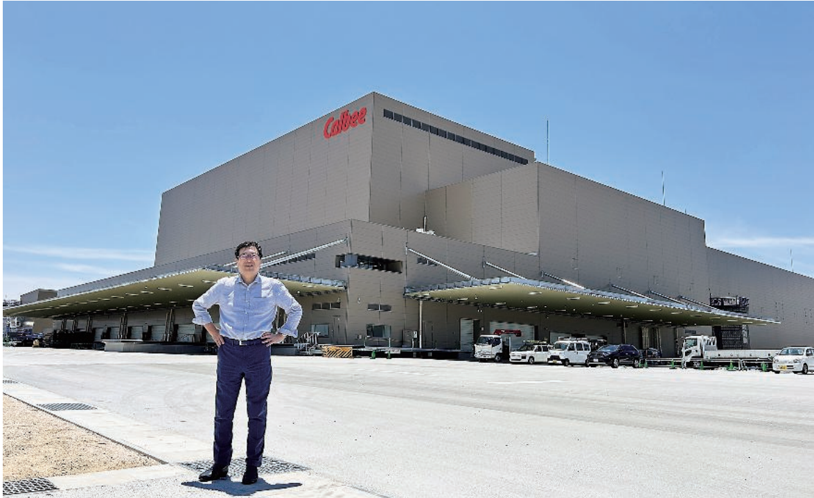
2024年 建築中のカルビーせとうち広島工場
