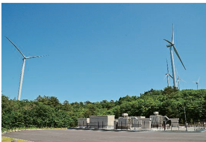
風力発電施設
