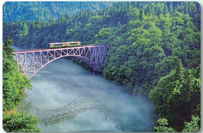
只見川第一橋梁
