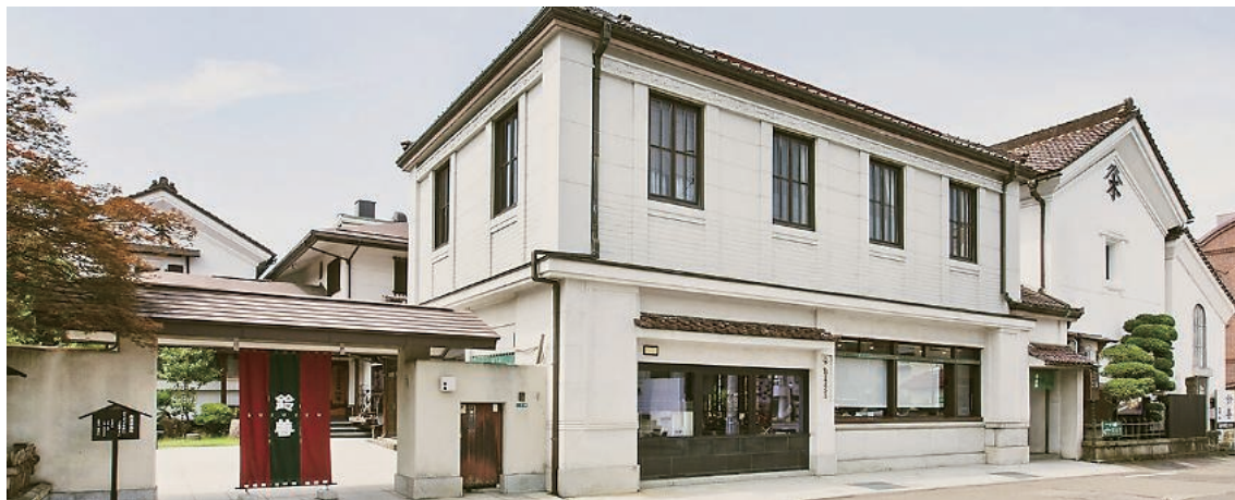
▲鈴善の蔵建造物群＝「会津塗伝承館」
